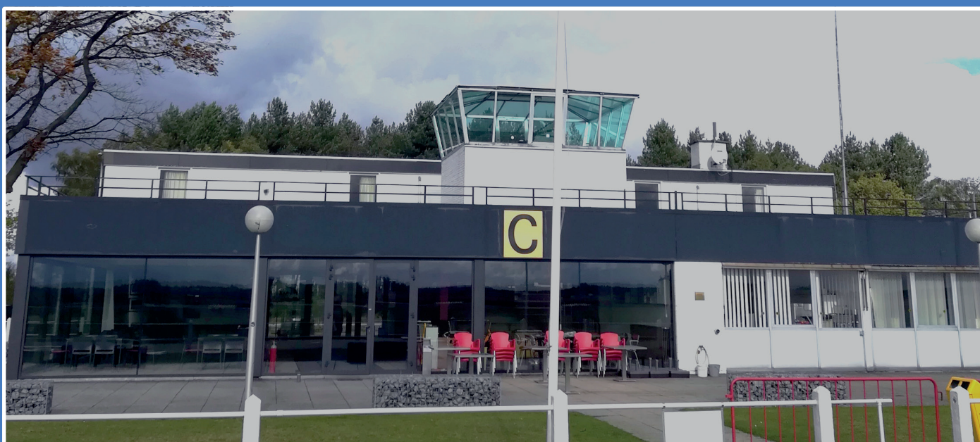
De vruchten van jarenlange inspanningen: ramen, portaal, interieur, elektriciteit, sanitair, verwarming, isolatie en leslokaal werden volledig vernieuwd. Klaar om u welkom te heten!
