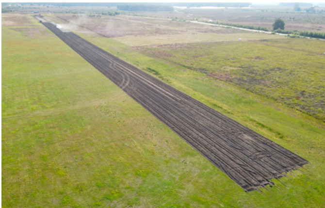
Losfrozen van de huidige asfaltlaag
