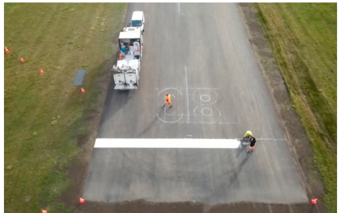
Nummering en belijning
