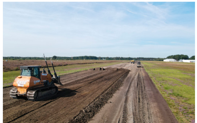
Uitmeten en vlaktrekken
