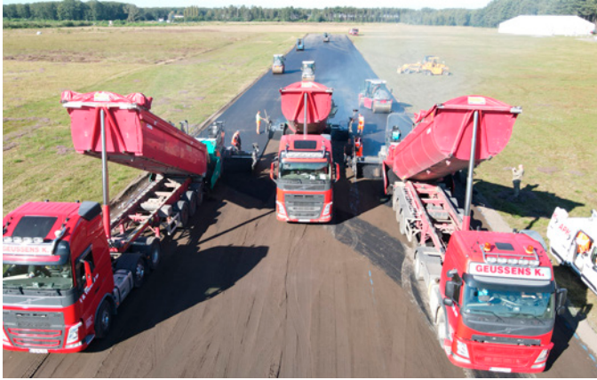
Bevoorrading van de asfaltermachines
