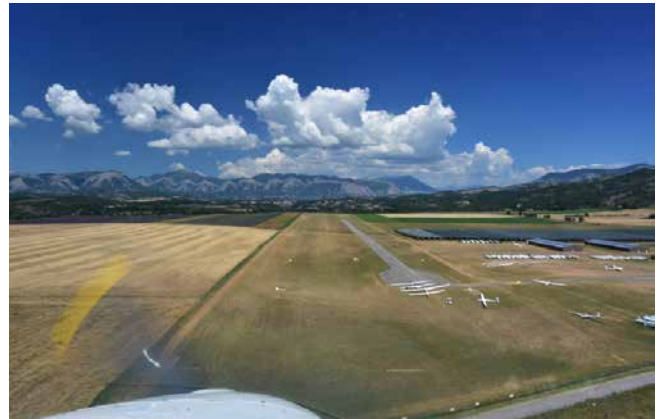
Aérodrôme Sisteron-Vaumeilh LFNS runway 35
